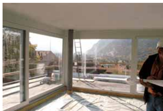
Attikawohnung B6 (Rohbau)
